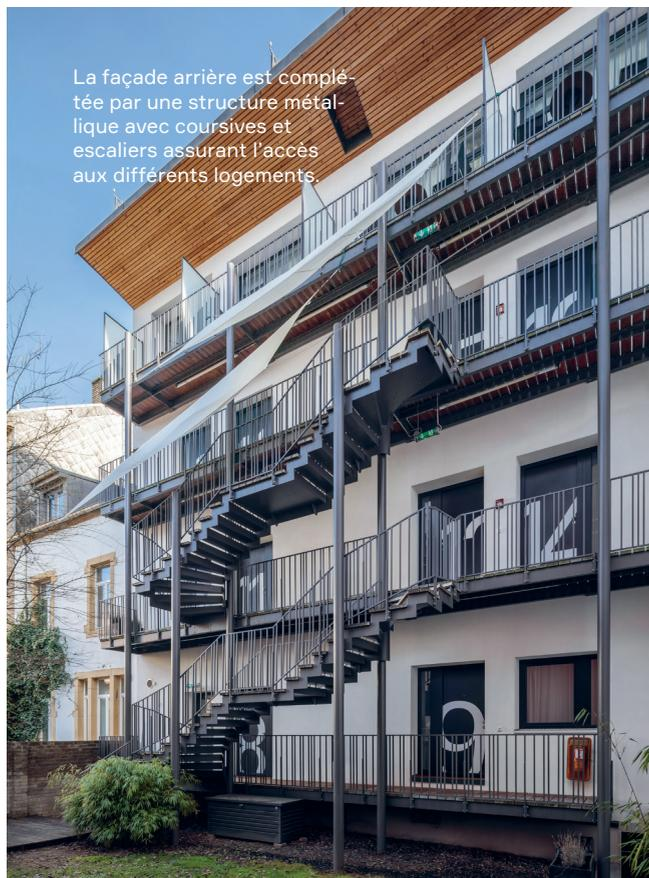
La façade arrière est complétée par une structure métallique avec coursives et escaliers assurant l'accès aux différents logements.
